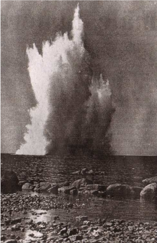
Merekaabli kaldalõigu kanali rajamine lõhkamisega.
